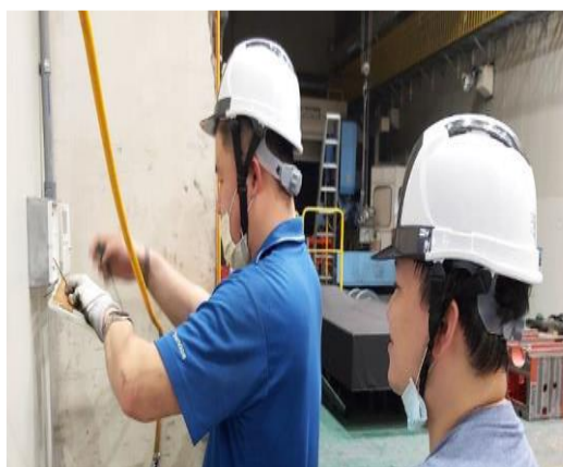
拆機環境確認：內外機 排水、配管線、電源等
